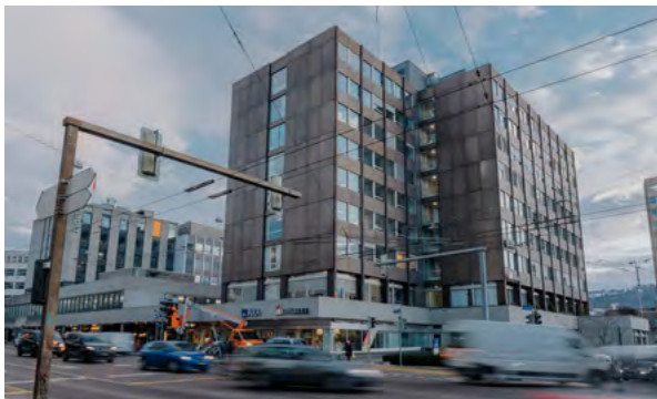
Hub an der Laupenstrasse 19
